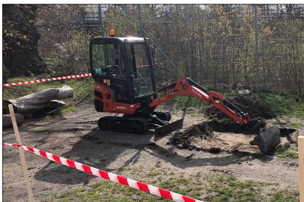
Etablering på Svandammsskolan och de första spadtagen för att förbereda spindelbygget.
