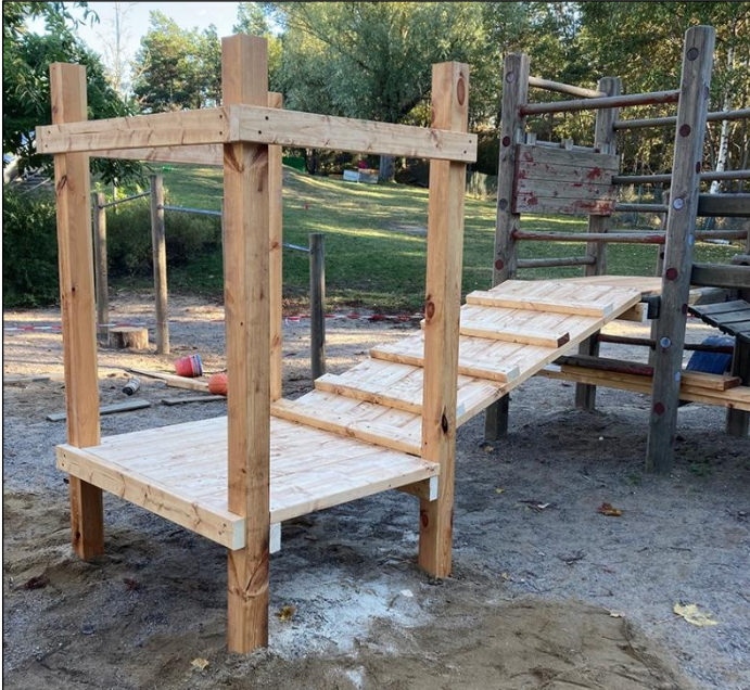
Den gamla klätterställningen byggdes ut och sämre delar togs bort.
