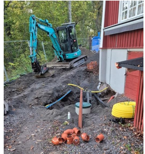
Trekammarbrunnen vid källardörren är på plats och nya rördragningar i källaren.
