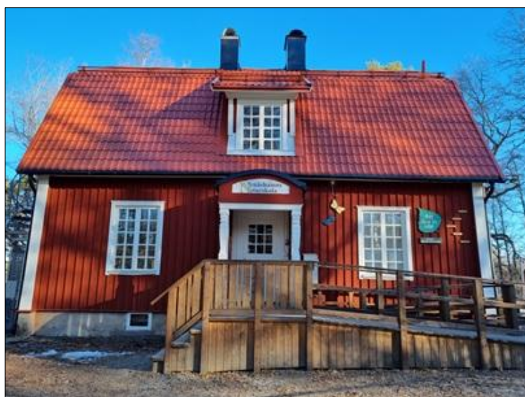
Det nya taket blev klart i februari 2024.
