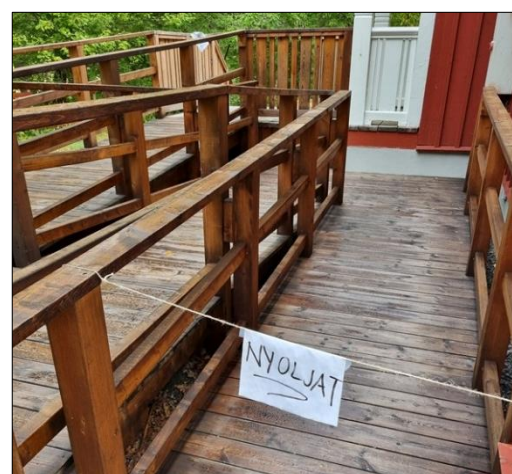
Rampen oljades inför hösten med hjälp av arbetstränande person.
